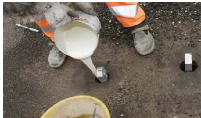
Figura 3 - 4 – Inserimento palo d'ancoraggio
