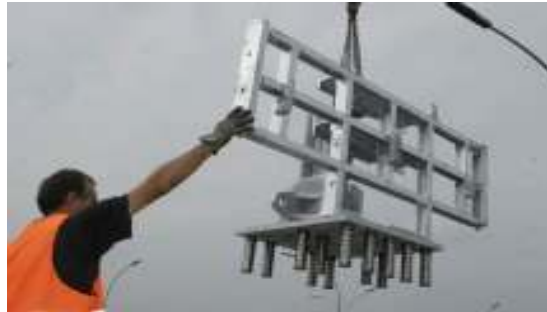
Figura 7 – Inserimento pilette nel supporto posteriore
