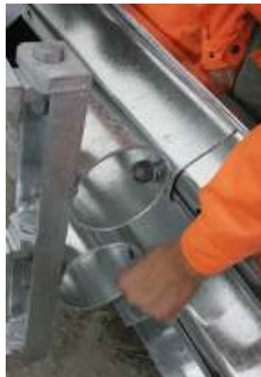
Figura 16 - 17 – Posizionamento lama 3N
