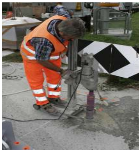
Figura 5 - 6 – Preparazione fori per supporto posteriore
