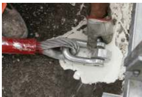
Figura 10 – Collegamento fune a pali d'ancoraggio
