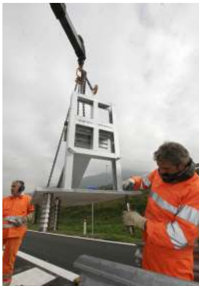
Figura 7 – Inserimento pilette nel supporto posteriore
