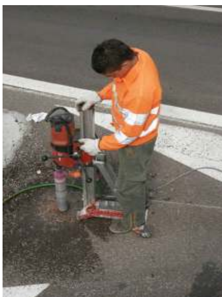
Figura 2 – Carotatura per i pali d'ancoraggio
