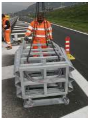
Figura 11 - 12 – Posizionamento TAU® preassemblato
