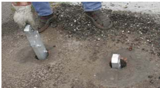
Figura 3 - 4 Inserimento palo d'ancoraggio
