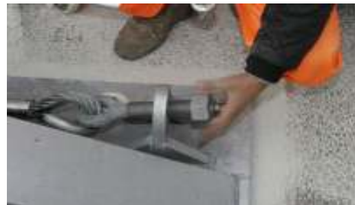
Figura 15 - 16 – Funi agganciate al supporto posteriore
