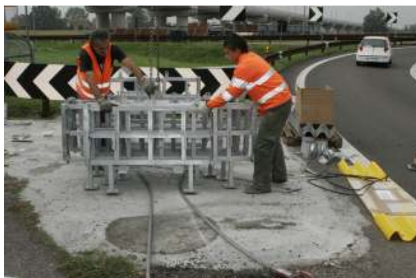
Figura 11 - 12 – Posizionamento supporti intermedi
