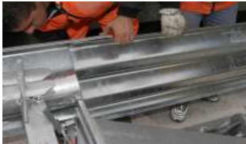
Figura 13 - 14 Fissaggio del TAU® preassemblato
