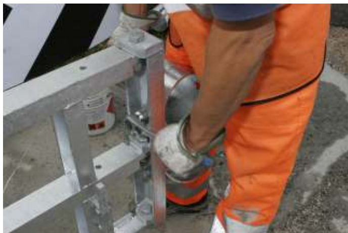
Figura 15 – Serraggio fissa lama
