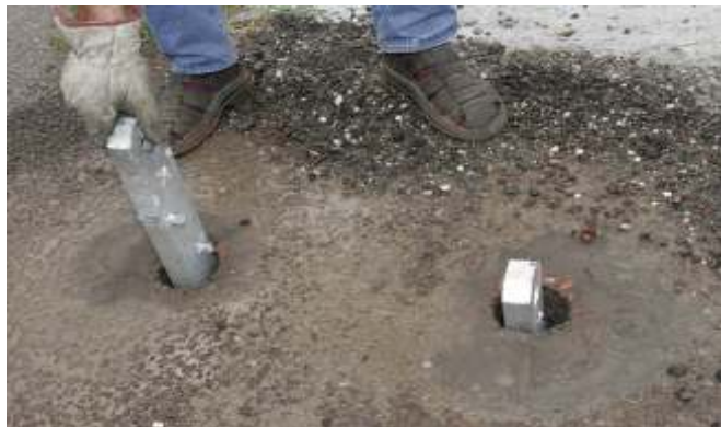
Figura 3 - 4 – Inserimento palo d'ancoraggio
