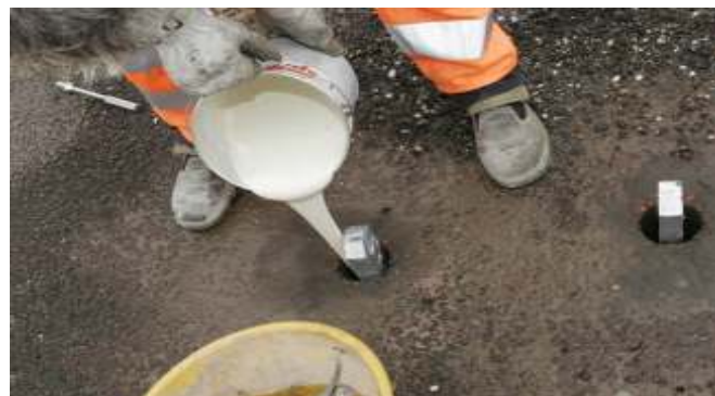
Figura 3 - 4 Inserimento palo d'ancoraggio
