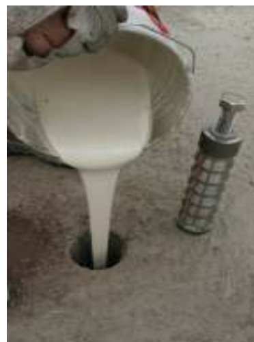
Figura 5 - 6 – Preparazione fori per supporto posteriore
