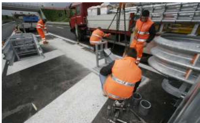
Figura 1– Posizionamento gruppo posteriore
