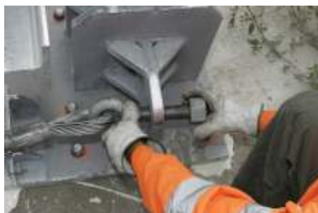
Figura 9 – Funi agganciate al supporto posteriore
