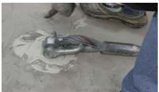
Figura 17 - 18 – Collegamento funi a pali d'ancoraggio
