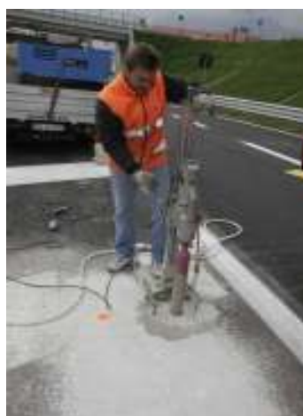
Figura 2– Carotatura per i pali d'ancoraggio
